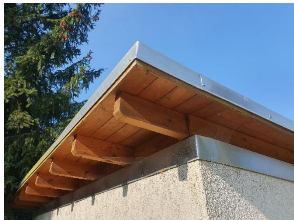
neues Dach Schuppen
