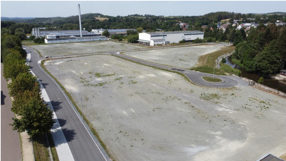
Drohnenaufnahme des Gewerbegebiets „Am Bahnhof“ Stand August 2024
